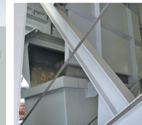
破砕材投入状況(木チップ)
